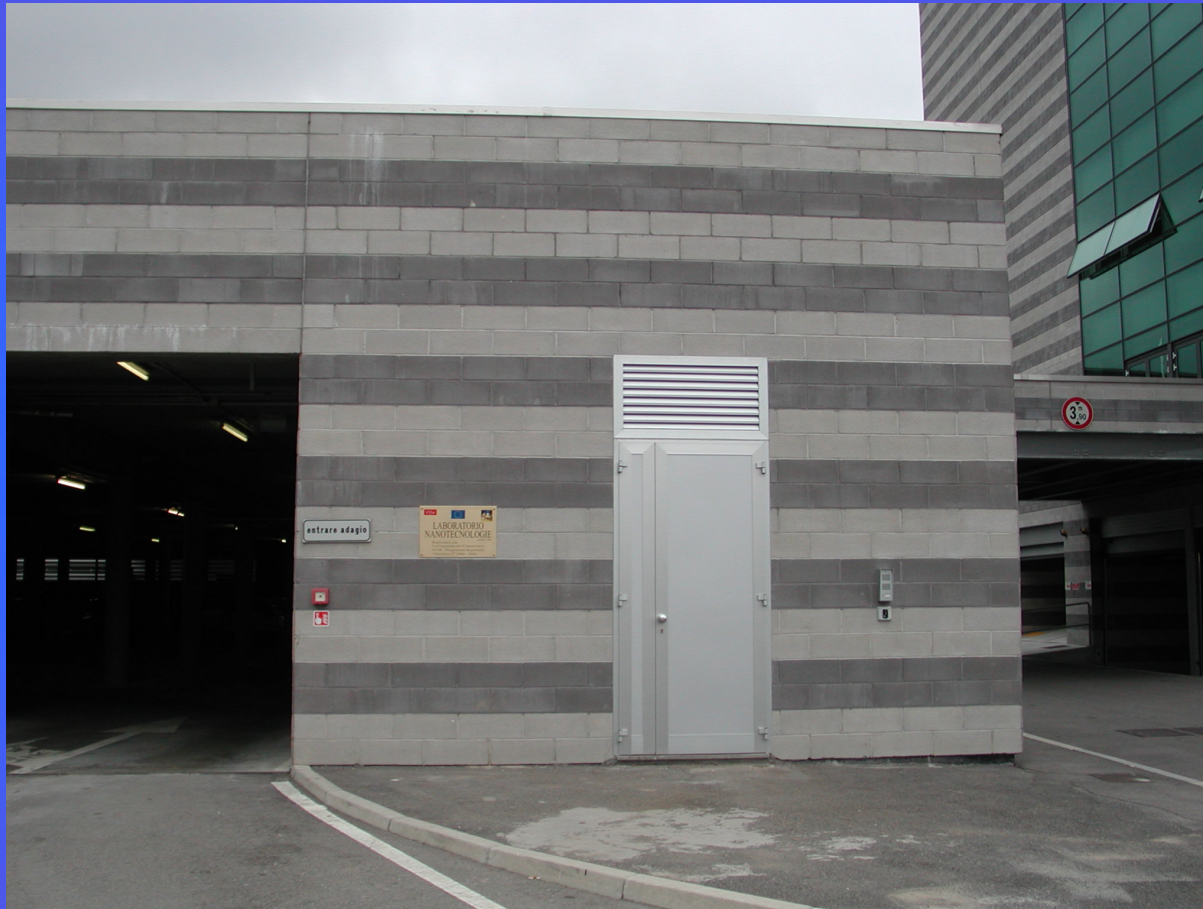
Ingresso Laboratorio Locale
