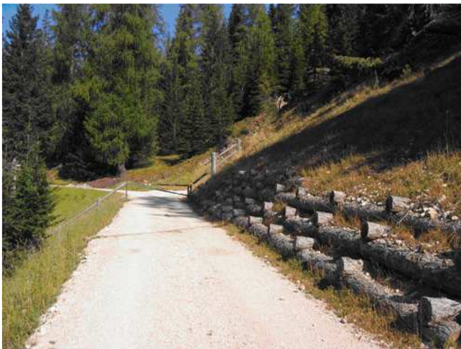
Fig. 16: strada della Valparola, muro di sostegno in tronchi
