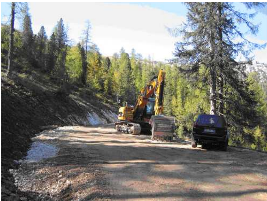
Fig. 16: strada della Valparola, cantiere secondo stralcio lavori
