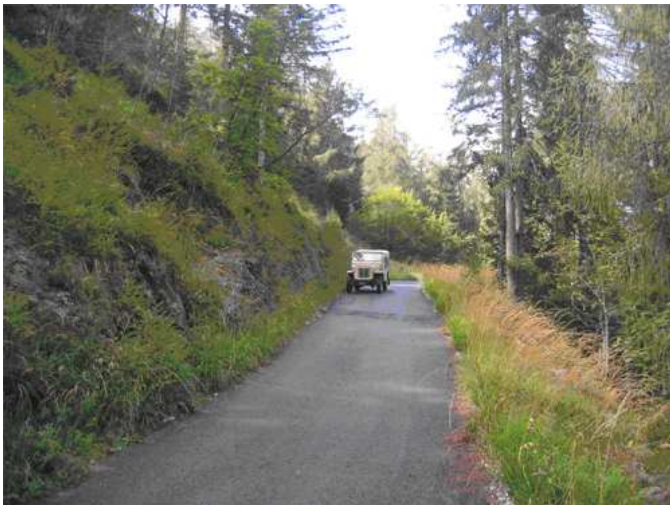
Fig. 11: tratto asfaltato della strada “malga Foca”
