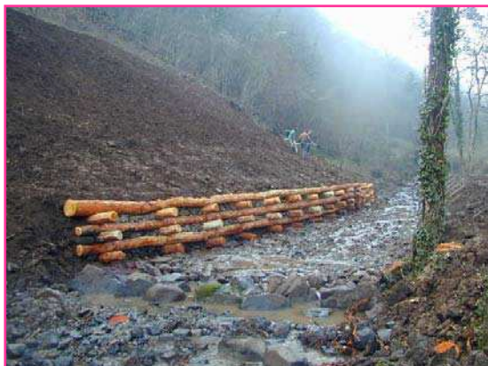
Esempio di difesa spondale durante l'esecuzione dei lavori e a lavori appena ultimati
