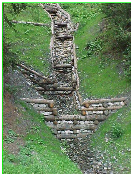
Esempi di canalette a lavori appena ultimati e dopo il rinverdimento
