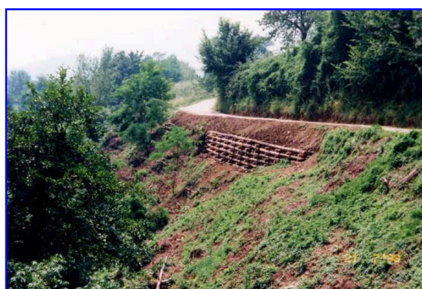
Esempio di arcie a sostegno di versanti in frana durante l'esecuzione dei lavori e a conclusione dell'opera
