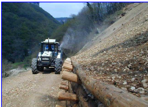
Esempio di arcie a sostegno di versanti in frana durante l'esecuzione dei lavori e a conclusione dell'opera
