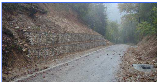
Esempio di gabbionate a sostegno di scarpate a monte e a valle della viabilità
