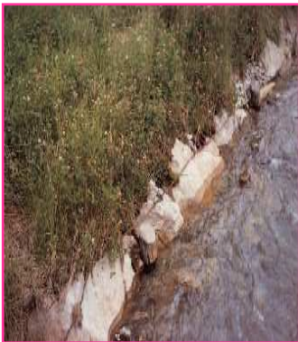
Esempi di difese spondali flessibili, in pietrame e in pietrame con inserimento di talee
