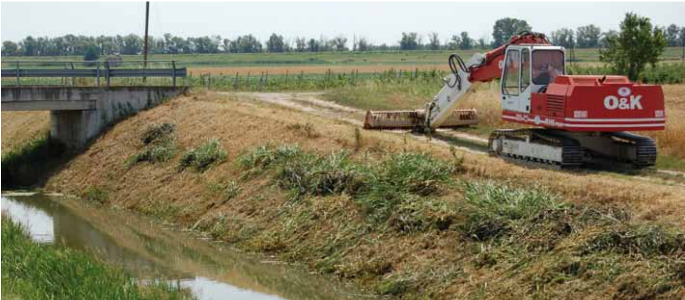
Taglio della vegetazione erbacea ripariale per la manutenzione dei canali di bonifica
