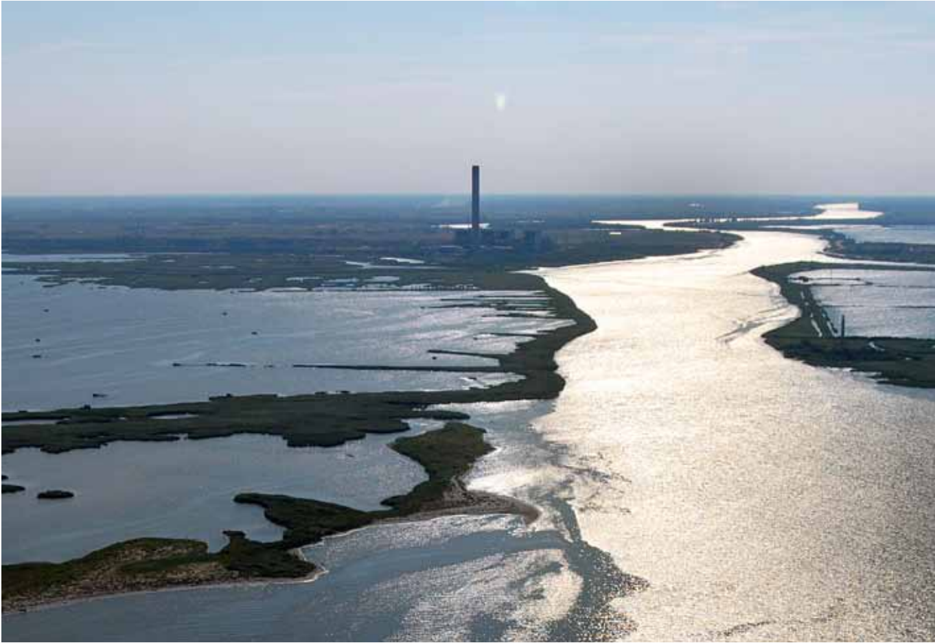
Vista del Delta, sullo sfondo la centrale termoelettrica di Polesine Camerini (Comune di Porto Tolle)
