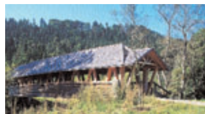
Ponte pedonale e ciclabile
