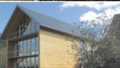
Edificio ad uso abitazione e uffici a St. Georgen
