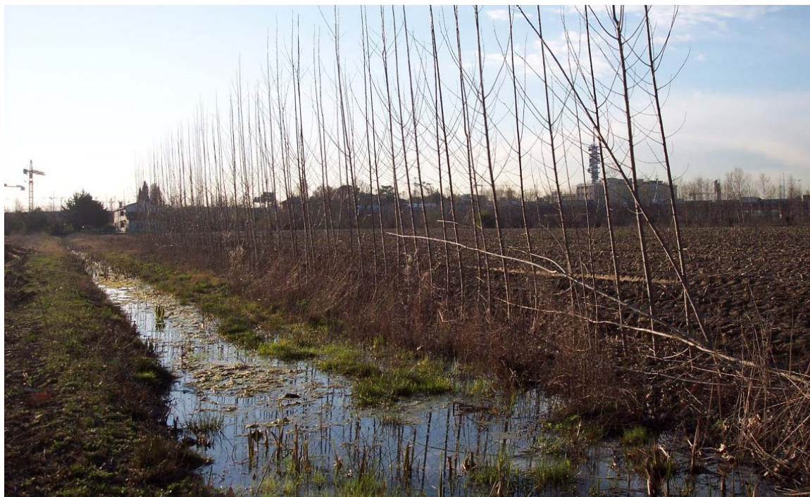
Figura 4. Esempio di canalizzazione in area di bonifica.
