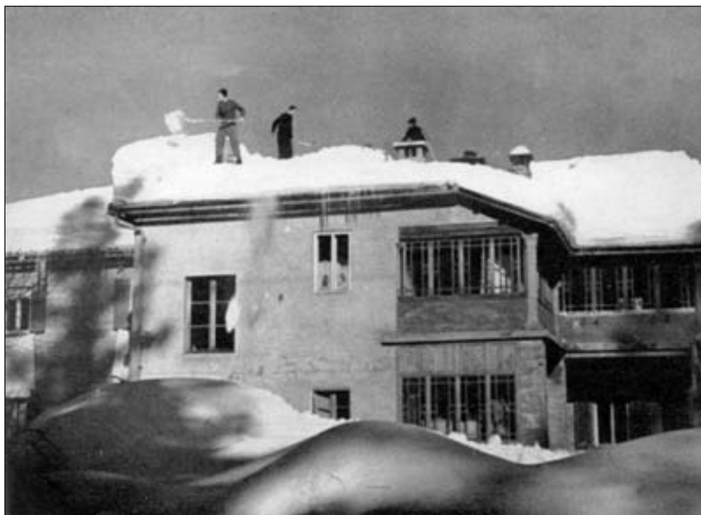
Faticoso lavoro per alleviare l'enorme peso della neve che minaccia la stabilità dei tetti.
