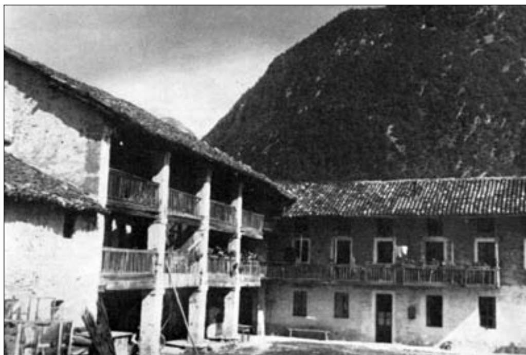
S. Gottardo: fabbricati del vecchio ospizio, ora ridotti a case coloniche
