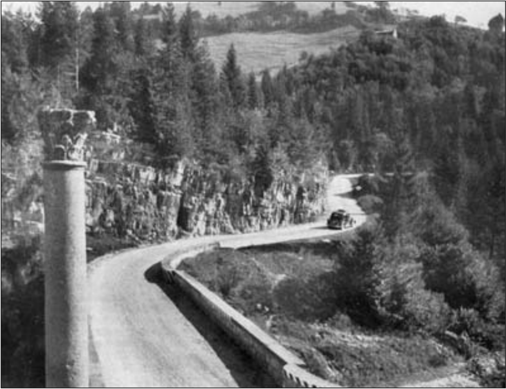
La pittoresca strada di Pove è scavata nei tipici banchi calcarei che formano l'ossatura del Grappa. (Foto Bruno Stefani)
