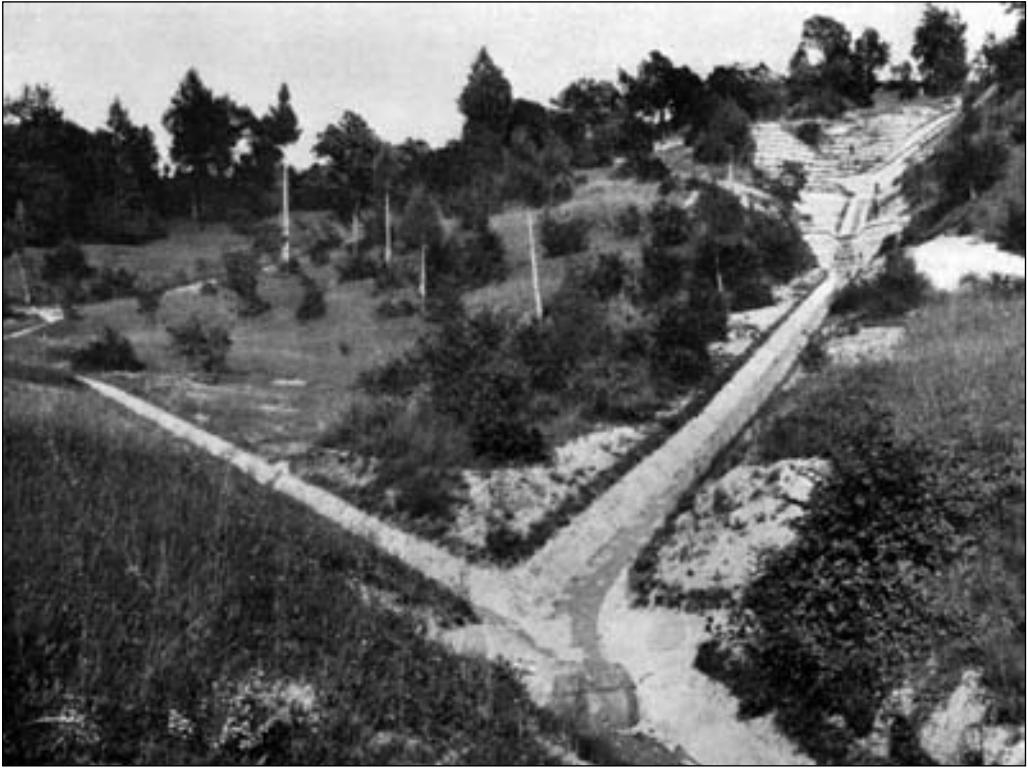
Sistemazione dei terreni franosi sui versanti del torrente Runal sopra Farra d'Alpago.
