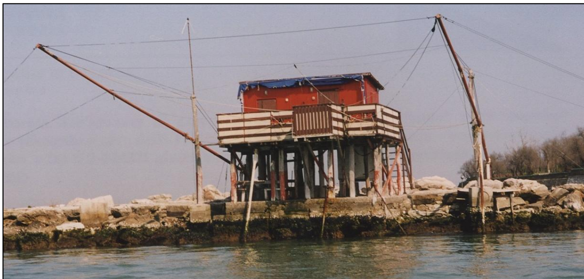
Foto 15.1 - Esempio di bilancione a due antenne
