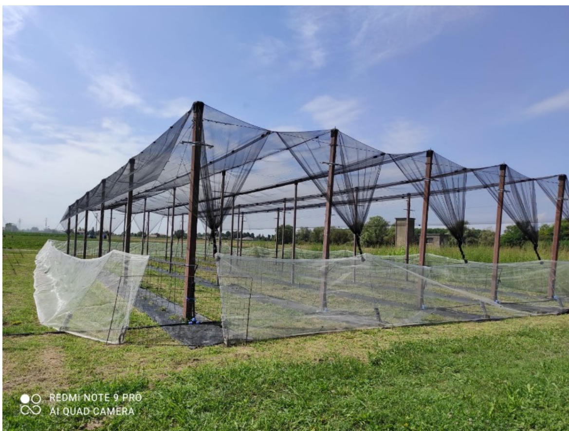
Impianto del luppoletto – vista dall'esterno
